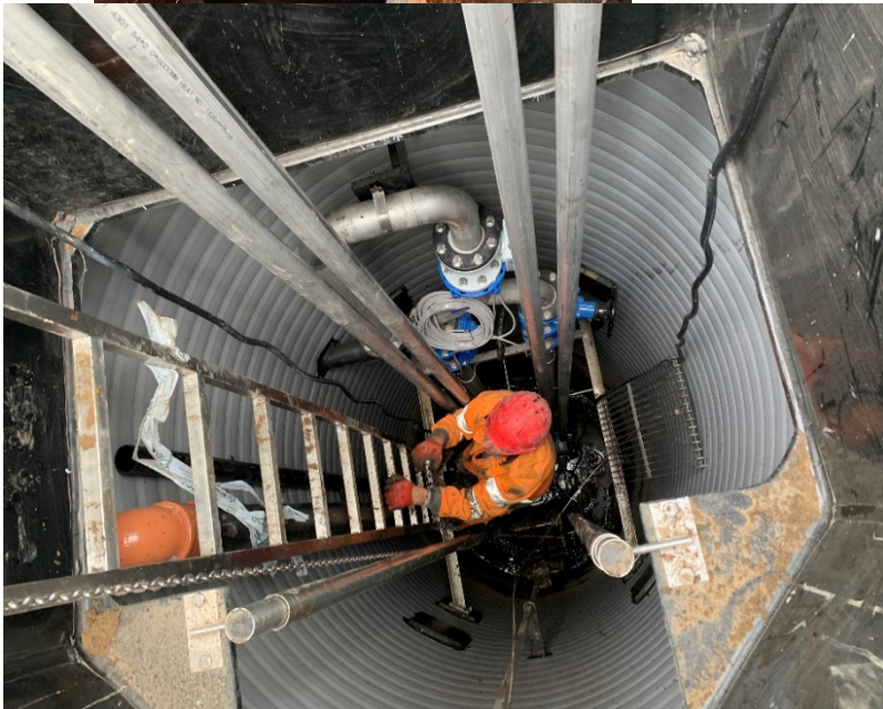
32 pav. Varėnos m. Spaustuvės, V. Krėvės, Transporto ir Statybininkų g. buitinių nuotekų tinklų statyba
